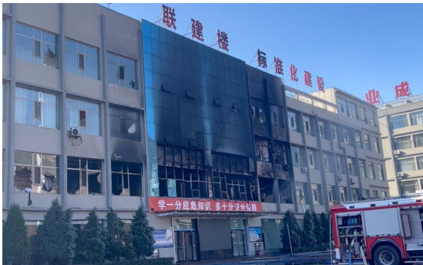
绝式压缩氧气自救器受高温后导致钢瓶内高压纯氧泄漏喷射，加速火势燃烧蔓延。高温有毒浓烟迅速弥漫整个二层，大量吊篮掉落影响疏散，在场部分人员没有第一时间逃生，造成21人死亡。烟气通过三、四层窗户向上卷吸，通过西侧和东侧楼梯间向上扩散，并向四层楼道弥漫，四层5人未能及时逃生，吸入有毒浓烟不幸遇难。
