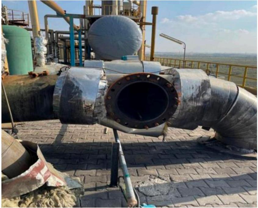
随后，装备制造公司维修工任伟等人对事故阀进行检修，将螺栓全部拆卸后，事故阀盖依然无法取下。杨亮到达现场，仅靠气化洗涤塔出口压力（17PT2013）DCS指示、就地压力表（17PG2002）读数和远传压力变送器（1210PI0001）DCS指示0MPa，判断系统内无气体压力。观察现场情况后，让任伟去取撬棍来撬事故阀盖。任伟取回撬棍，杨亮开始撬阀盖，其他区域工作人员随后到达现场将检测仪递给杨亮，此时平台共
