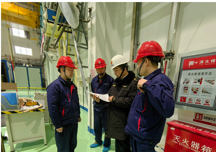
该局检查西安西电变压器有限责任公司复工复产情况
