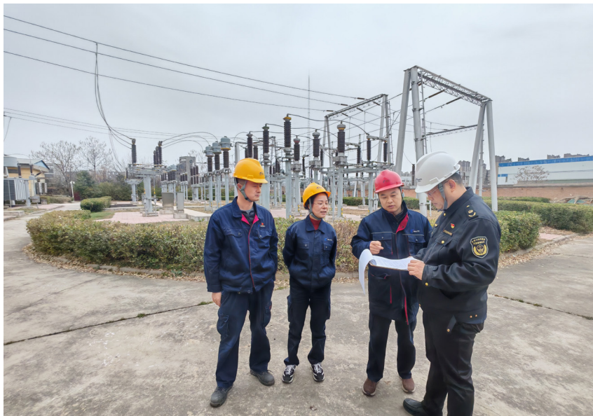
宝鸡市应急管理综合执法支队对宝钛股份有限公司开展专项检查
