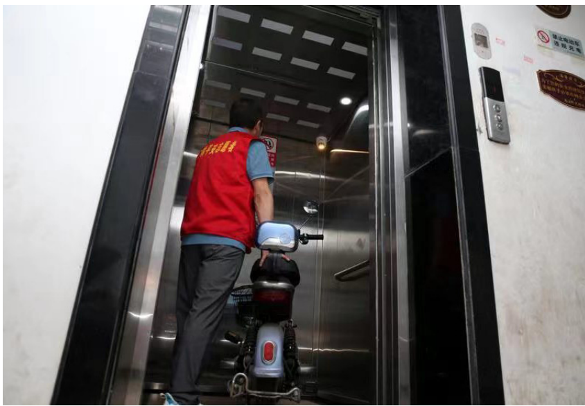
该区工作人员验证高层住宅电梯智能拦阻电动车效果
