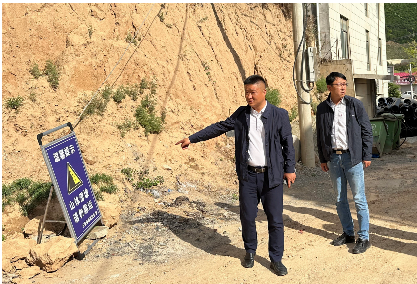
该镇分管领导实地检查指出告示牌太小且摆放位置不对的问题
