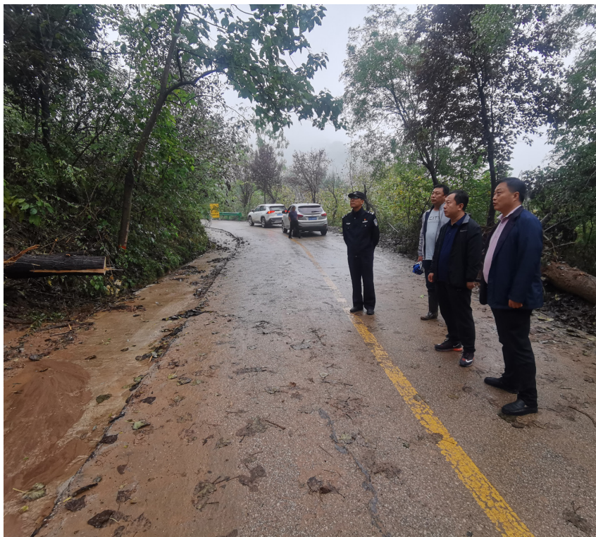
汛期该局工作人员加强巡查检查防止地质灾害发生
