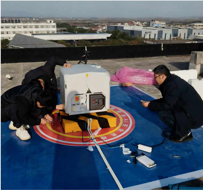
该局工作人员安装调试无人机机巢
